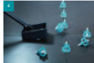
4 Krytku sejměte pomocí odstraňovače nivelačního systému BIHUI a znovu použijte.
