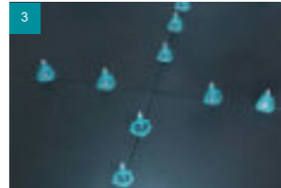
3 Krytku našroubujte/dotáhněte na požadovanou úroveň tak, aby nevzniklo přesazení.
